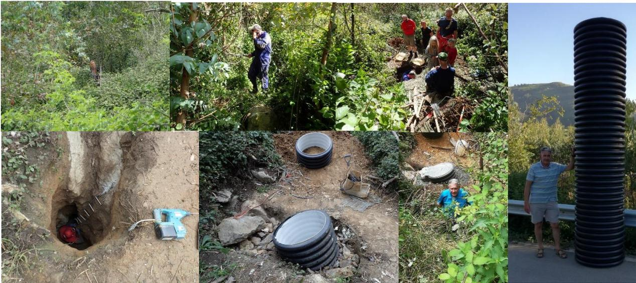
**SubPhone Entrada (4536) – ubicando el punto arriba de la estación SubPhone en la cueva, excavando, instalando el tubo y hormigoneando alrededor de la tapa**
